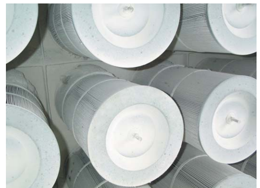
Gasturbinen-Zuluffiltration in Kreidewerk (GTC 327)
